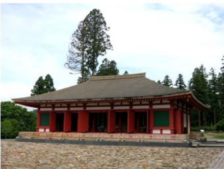
復元された金堂。建立当時の建築技法で再現されています。
